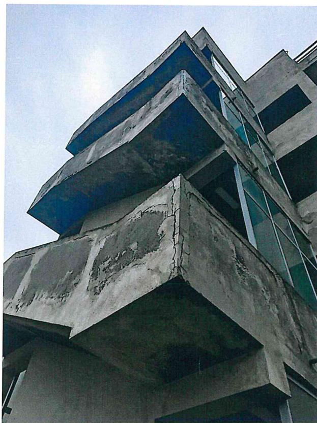
La situazione della gradinata Ovest è ancora più preoccupante in quanto presenta diffusi distacchi sia di intonaco che del copriferro su solette, gocciolatoi e parapetti.
