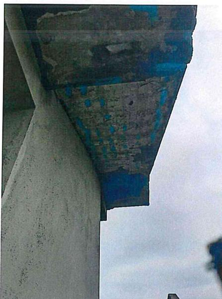
Da una delle solette rampanti della gradinata Est lato Ospedale si è verificato il distacco di una porzione di intonaco che è rovinata a terra e causando una situazione di pericolo per l'incolumità pubblica in quanto, in detta gradinata, transitano numerosi dipendenti dell'Azienda che dopo aver parcheggiato nel silos multipiano, scendono da detta scala per recarsi sul posto di lavoro.
